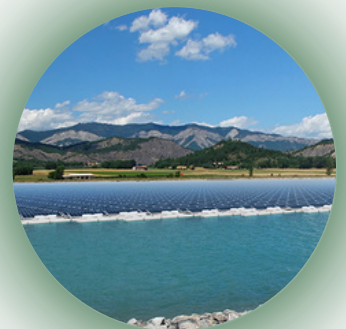
Site d'implantation de la centrale photovoltaïque de Lazer
